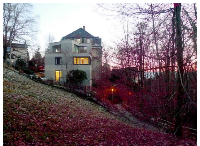
Das Haus dicht am Tobelweg im Wald des Doldertals
