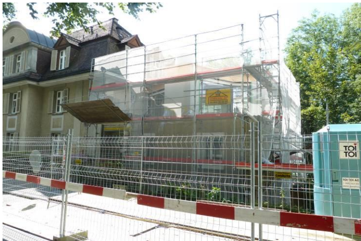
Der Terrassen-Aufstockungs-Bau für zusätzlichen Raum dauert,
